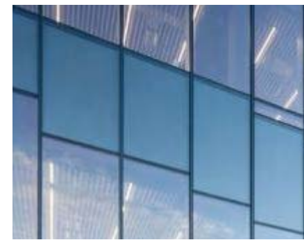
11. Curtain Wall Spandrel
