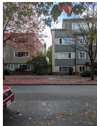
1 Existing Site (Burnaby)
